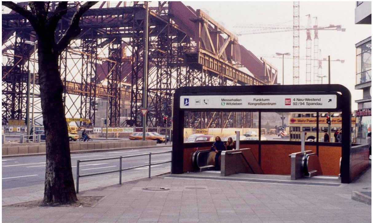
Rolf Goetze: Das ICC im Rohbau, 01.02.1977
